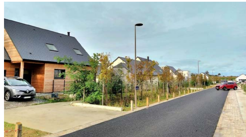
Exemple de traitement de l'espace public, quartier des haut-prés, Douvres-la-Délivrande (14), Nexity
