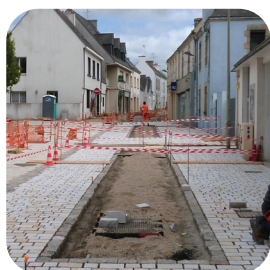
Travaux Grande rue
